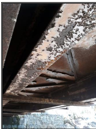
Pohled na spodní stranu mostku – dvojice nosníků I 400 se spodním spřažením profily U120 a ztužením mostovky ležatou příhradou z prutů L 60/60/6 mm
