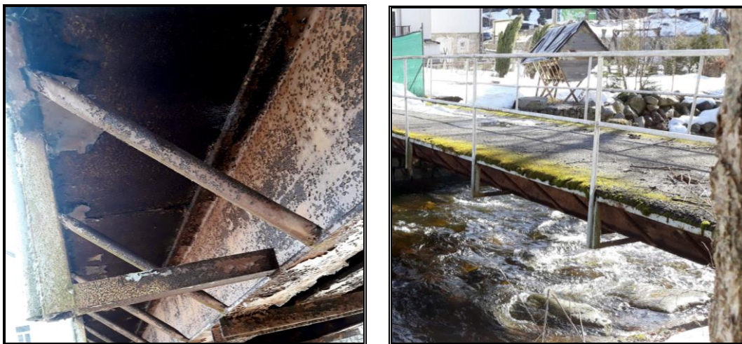
Trubkové vzpěry krajních konzol mostku a svařence se zábradlím
