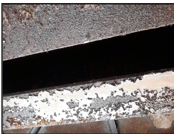
Pohled na spodní stranu mostku – dvojice nosníků I 400 se spodním spřažením profily U120 a ztužením mostovky ležatou příhradou z prutů L 60/60/6 mm
