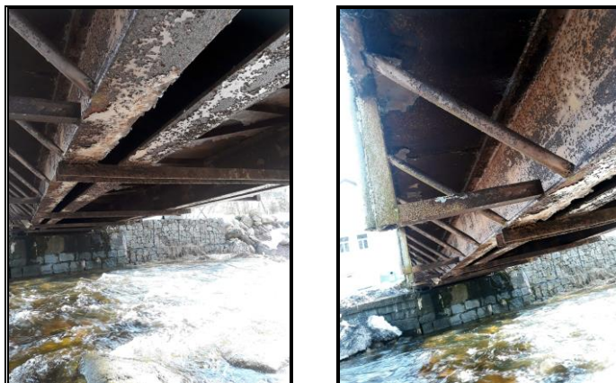
V pozadí je opěra s železobetonovým prahem na kamenném soklu, vpravo po vodě jsou gabionové zdi.
